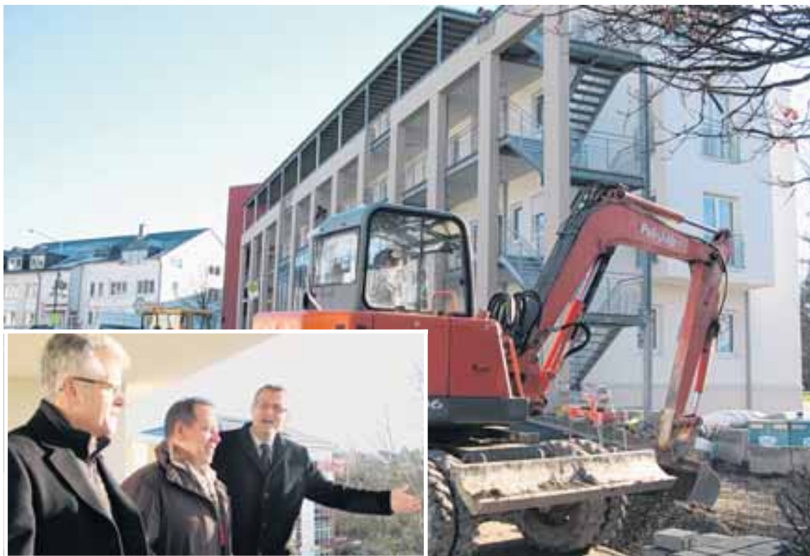
Fast fertig: Mitte Dezember sollen die Arbeiten an der neuen „Residenz am Stadtpark“ abgeschlossen sein. Der 3,5 Millionen-Euro-Bau steht in unmittelbarer Zentrumsnähe und dennoch im Grünen. Projektentwickler Stefan Kutscheid zeigt Kurt Reichel und Rainer Kropidowski (von rechts), denen Gewerbeflächen im Gebäude gehören, den Blick auf den Stadtpark.
